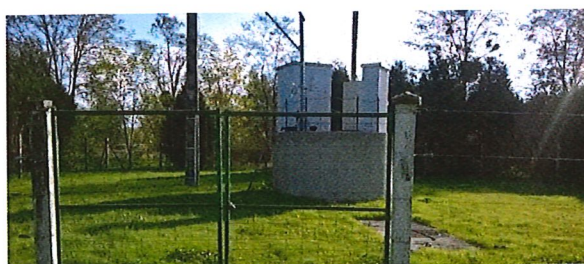
Station de pompage Châteauneuf sur Cher
